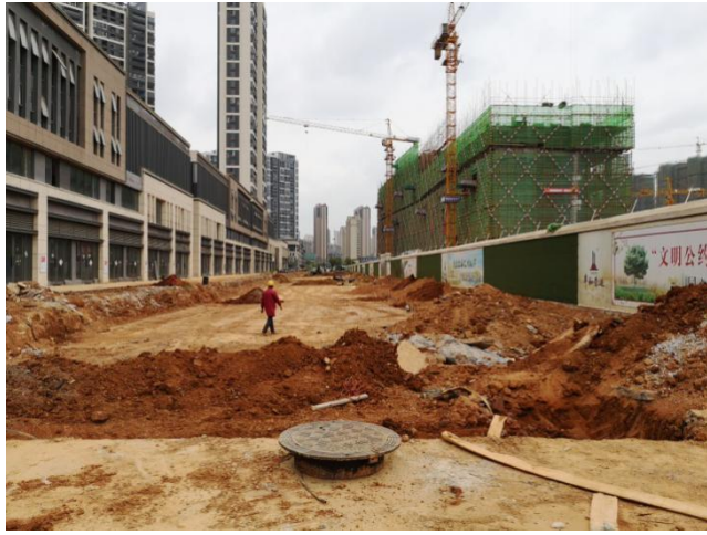
新院区西北侧为在建水南路、中航云府二期
