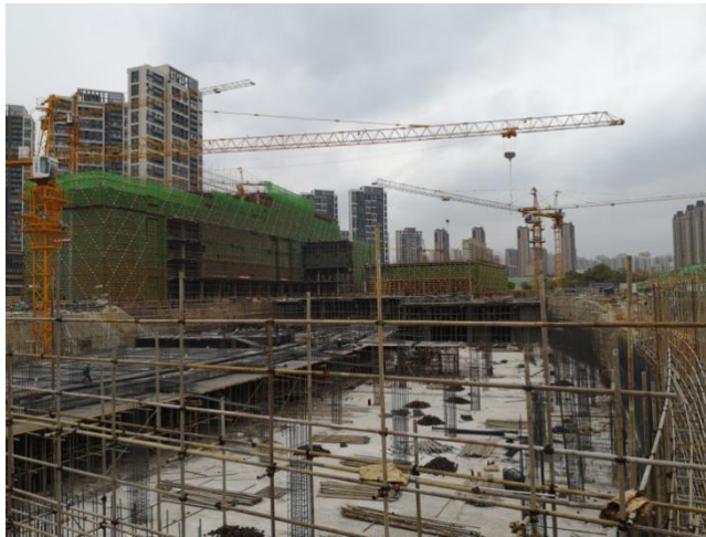
新院区在建工地
