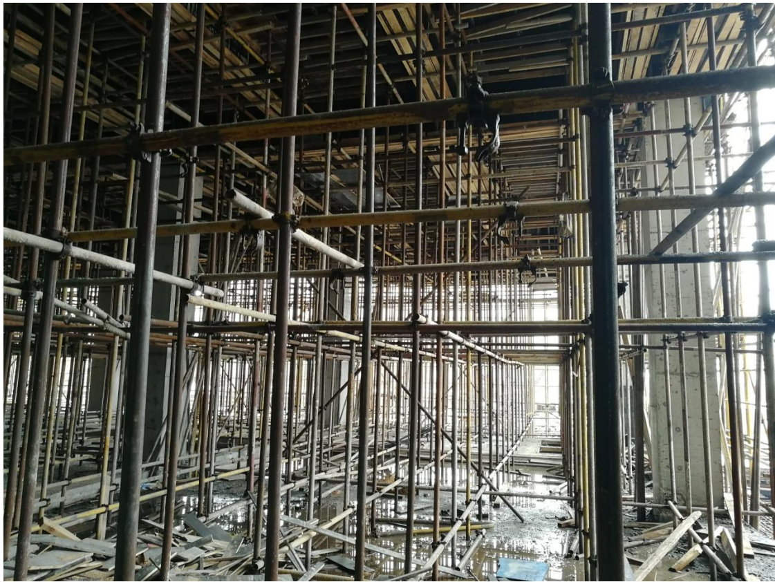
新院区门诊医技楼 1F 介入中心 (DSA 机房)
