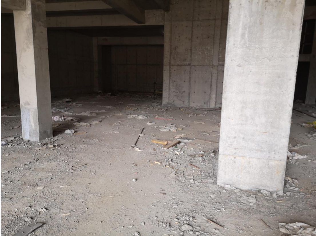
新院区门诊医技楼-2F 放疗中心
