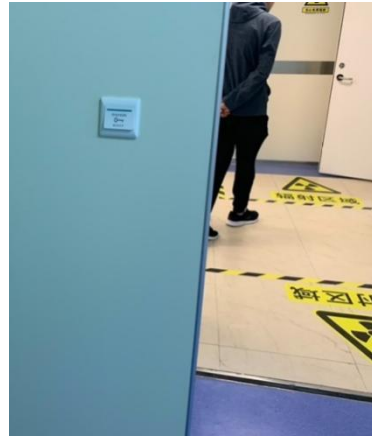
控制室操作台紧急开门按钮
